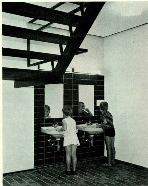
Afb. 5. „Poetsinstructie”. De wastafels zijn op een dusdanige hoogte aangebracht dat kinderen vanaf vier jaar er gemakkelijk bij kunnen en goed in de spiegel kunnen zien.
