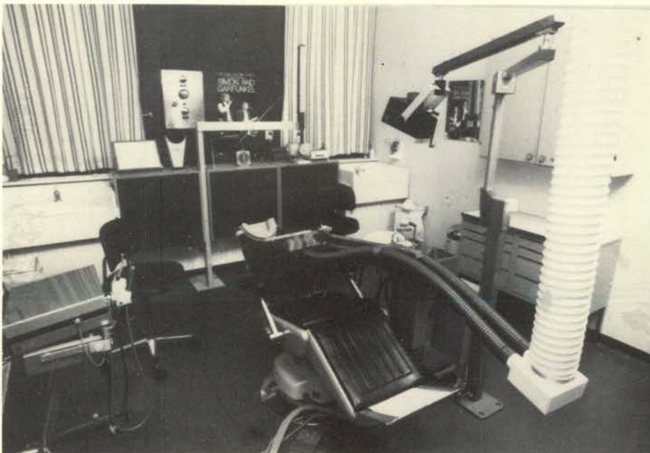
Afb. 2. Plaatselijk afvoersysteem. Overzicht van de evacuatiekanalen, gekoppeld aan de – onder een manoeuvreerbaar instrumentenblad gemonteerde – afzuigmond.
